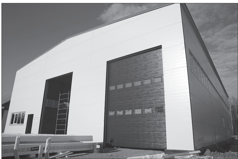
Строительство бокса для ремонта крупногабаритной техники
